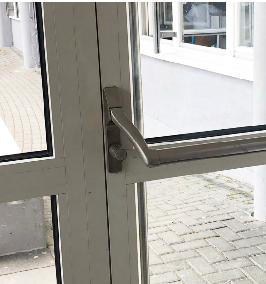
CES OMEGA FLEX anti-paniekcilinder op een nooddeur
