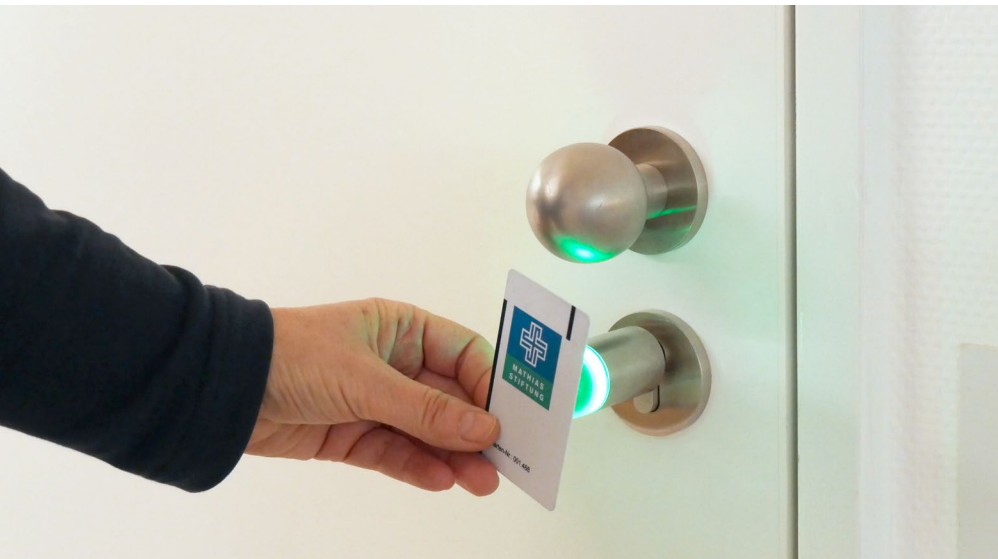
Zutrittsberechtigung an einem kabellos installierten Elektronikzylinder. Bei der Umstellung des mechanischen Schließsystems auf die Zutrittskontrolle muss an der Tür nichts verändert werden. Ein mechanischer Zylinder wird einfach durch einen Elektronikzylinder ersetzt.
