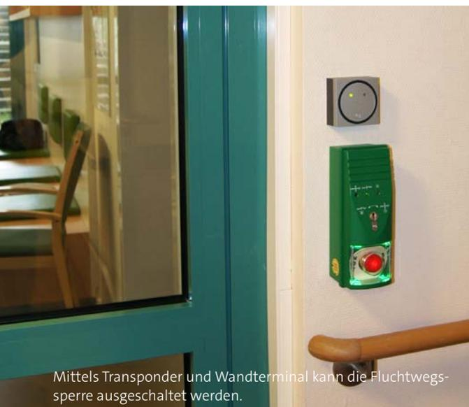
Mittels Transponder und Wandterminal kann die Fluchtwegssperre ausgeschaltet werden.
