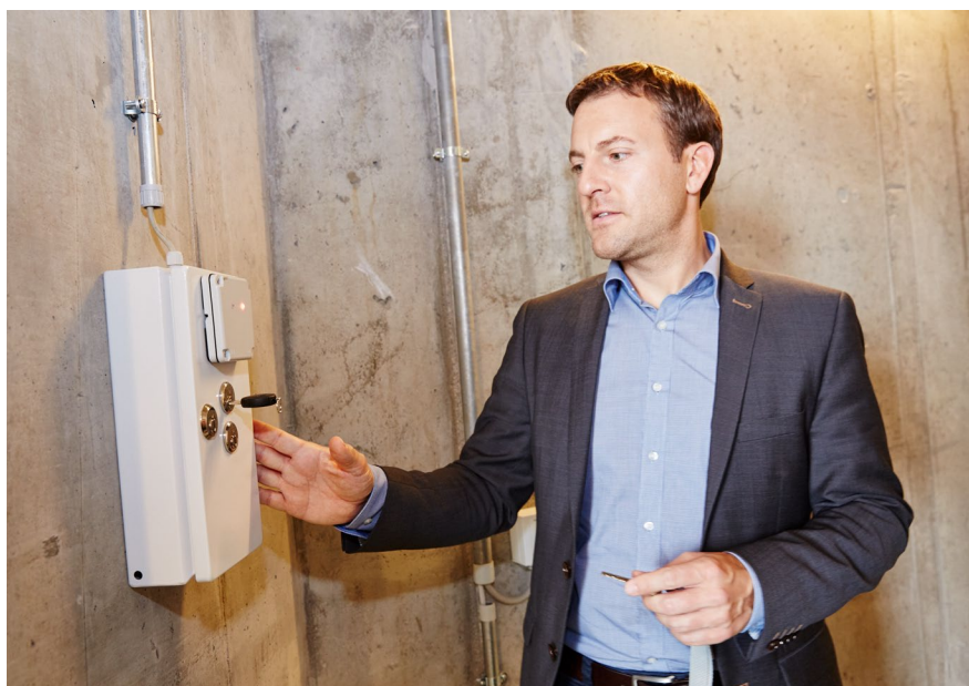
Les coffres à clés installés dans les cages d'ascenseurs (ici modèles montés en applique) garantissent un retrait de clé sans déclenchement d'alarme et offrent une solution de secours fiable. © Claudia Höhne
