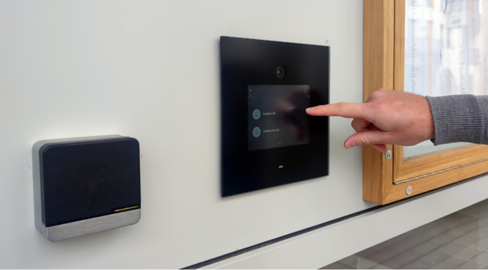
Wie een sluitmedium heeft, krijgt toegang via de Updater (li.), die het toegangsrecht controleert en de deur vrijgeeft. Alle anderen melden zich aan bij het intercom-paneel (re.). © CES
