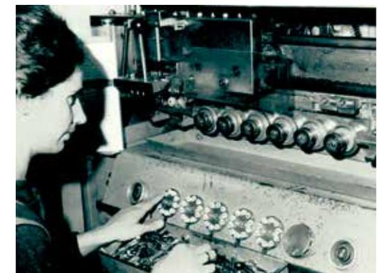
Einrichten der Schlüsseleinschneidemaschine
