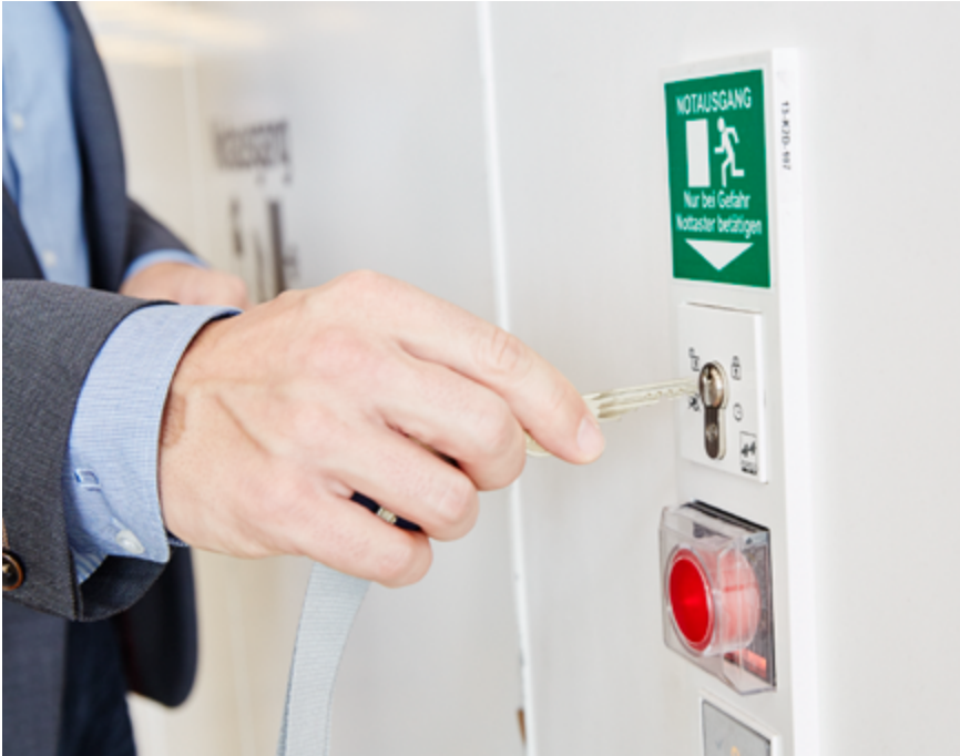
In de vluchtdeurterminal zit een sleutelschakelaar waarmee de deur voor langere tijd open kan blijven.
