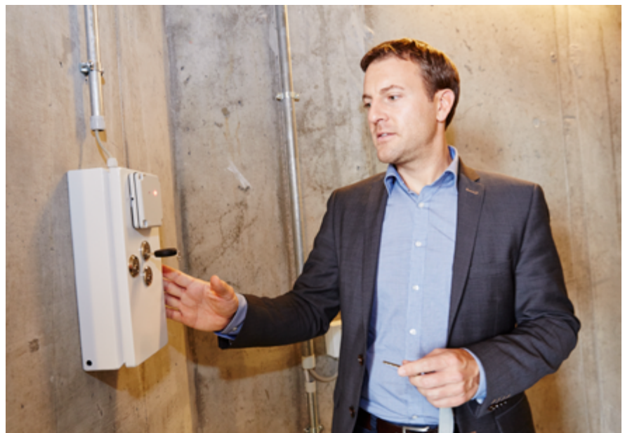
Bij de sleutelkluisjes, die onder andere in de liftschachten zijn aangebracht (hier als opbouwkast), kan via een elektronisch beveiligd proces een sleutel worden uitgenomen. Dit is een betrouwbare back-upmogelijkheid.
