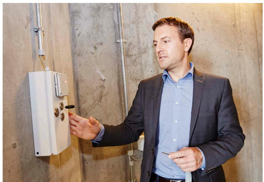
Die unter anderem in den Aufzugsschleusen angebrachten Schlüsseltresore (hier als Aufputzvariante) gewährleisten eine elektronisch abgesicherte Schlüsselentnahme und sorgen für ein zuverlässiges Backup.
